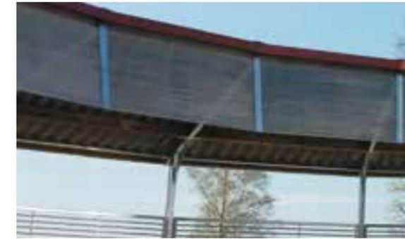
KRAFT Boden-Führanlage mit Windschutznetz
