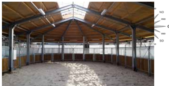
Nouvelle construction d'un marcheur sur rails de 15,5 m x 28,5 m
