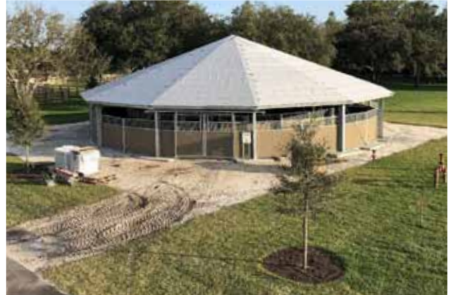
Nouvelle construction y compris plantation de compensation
